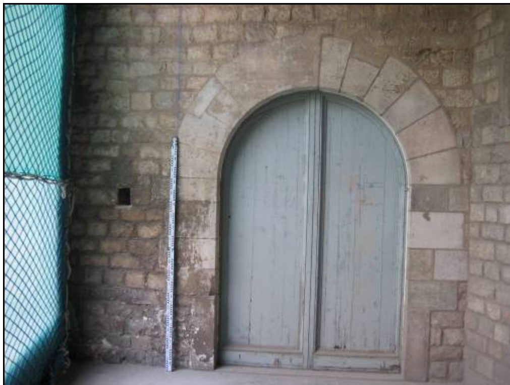
Fotografia 19. Detall de més a la vora de la paret 1.
