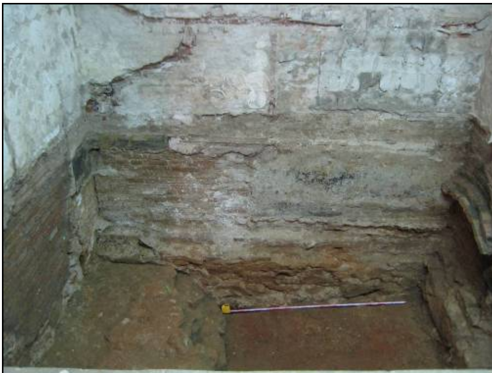
Fotografia 13. En aquesta fotografia es pot apreciar com la fonamentació del mur del segle XIX es recolza sobre de la muralla romana.
