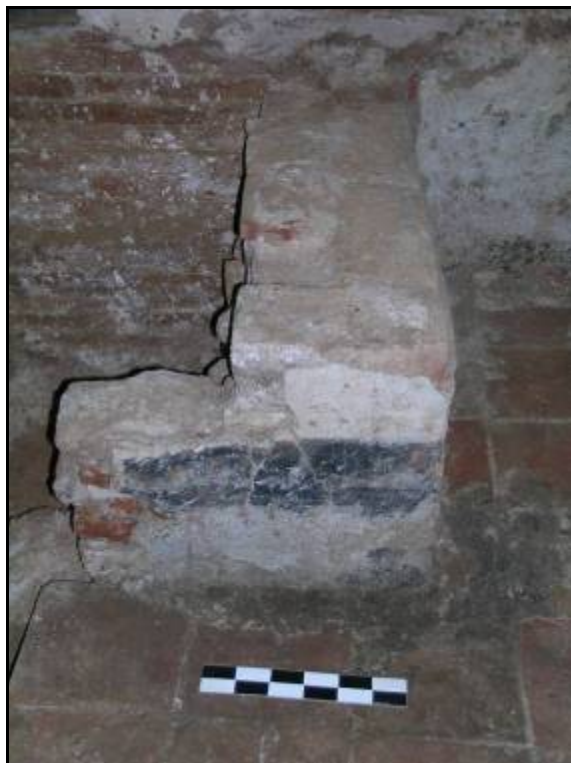
Fotografia 5. Detall frontal del mur U.E.114.
