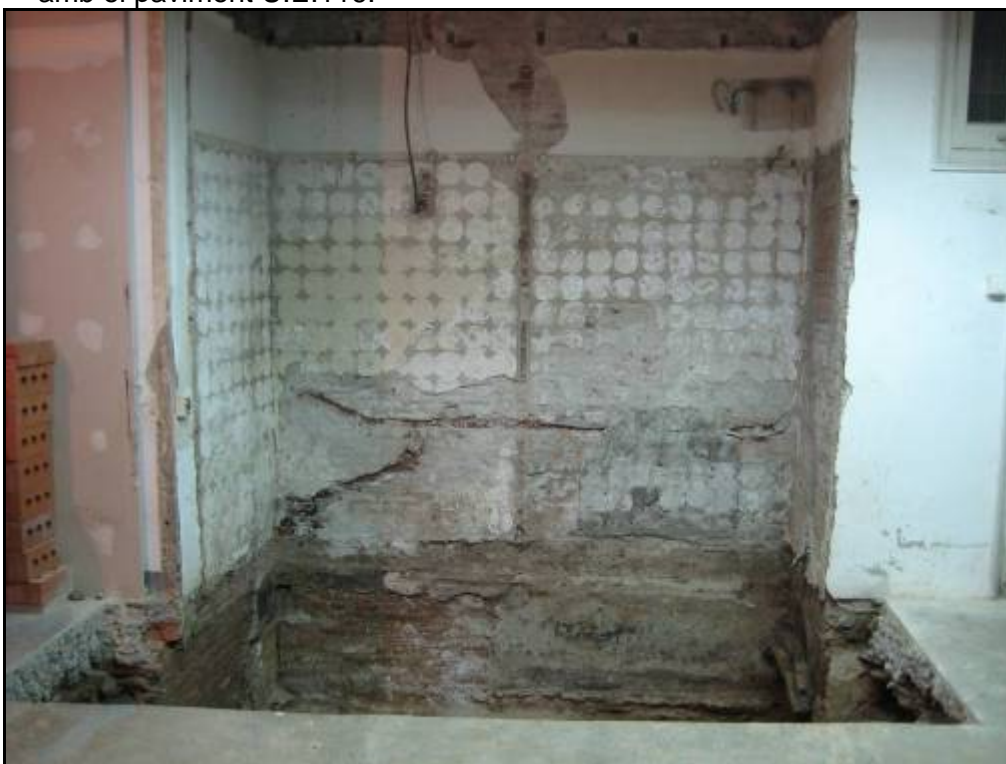
Fotografia 10. Detall de l'espai que ocupa el fossat del muntacàrregues.
