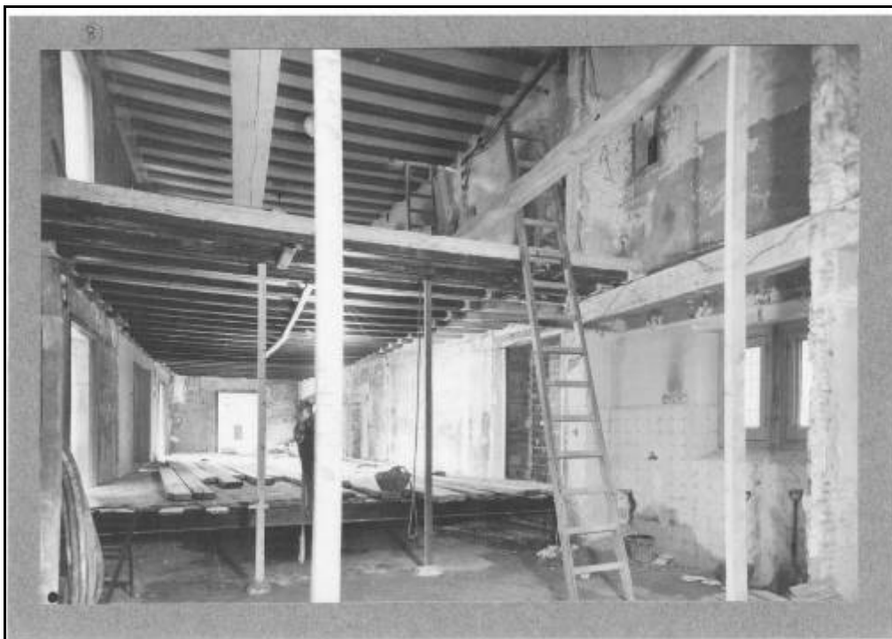
Fotografia 25. Detall de la paret 3 durant les obres dutes a terme al segle XX. (Arxiu Closa)
