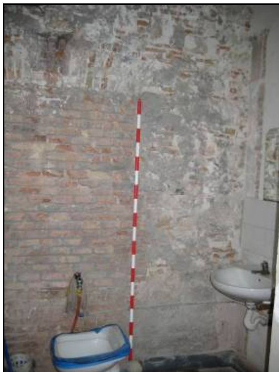
Fotografia 28. Detall de més a la vora de la paret 4.
