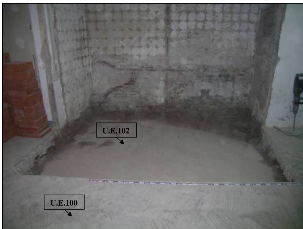
Fotografia 1. Detall dels paviments U.E.100 i U.E.102.
