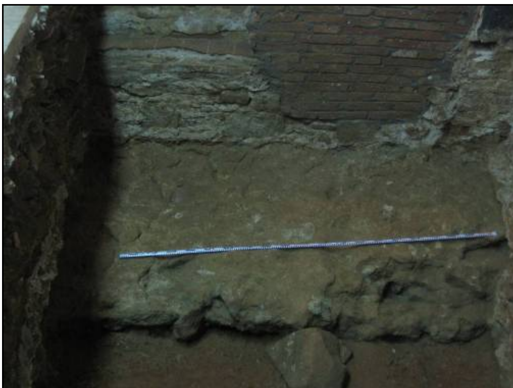
Fotografia 12. Detall de la muralla on es pot observar l' opus caementicium .
