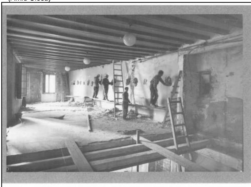
Fotografia 26. Detall de la paret 3 durant les obres dutes a terme al segle XX. (Arxiu Closa)
