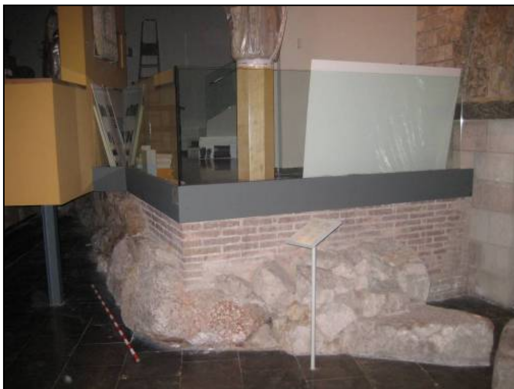
Fotografia 16. Detall del tram de muralla situat a l'interior del Museu.
